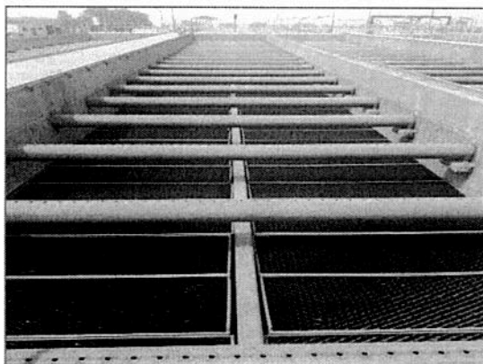
Figura 3. Sedimentador laminar.
